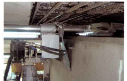
橋座狭陰部はつり
