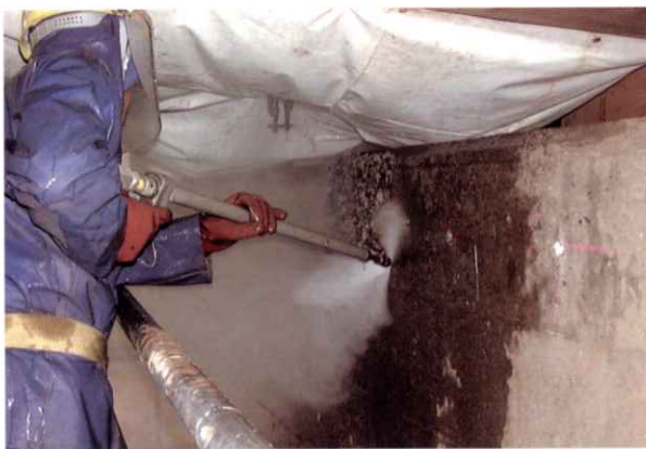
橋脚横梁はつり
