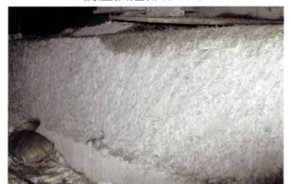
橋台堅壁はつり
