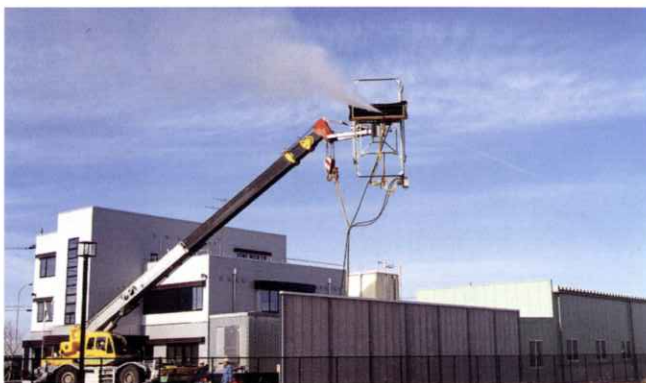
ジェットフレーム通水試験
