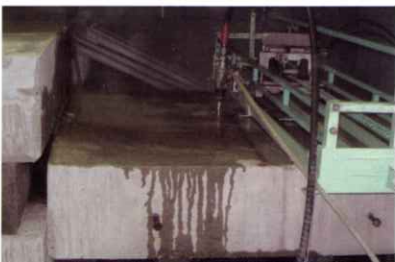
コンクリート切断試験
