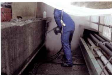
地覆側面はつり
