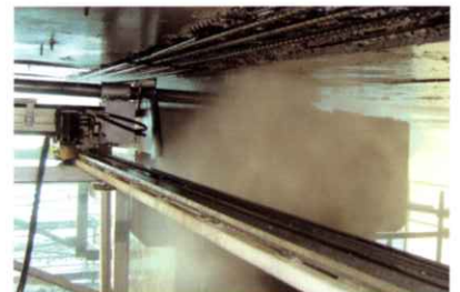
支承狭陰部はつり
